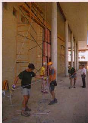
Preparación de los circuitos sin fin.
